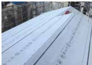
下地材を施工
