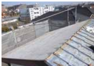
瓦をおろし下地をチェック
